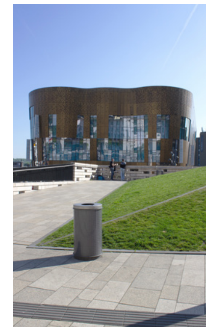
Abbildung 3 ▲ Geschäftshaus am Neuen Döppersberg
